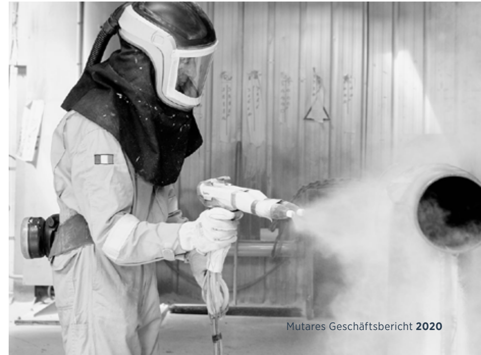
Erhitztes Rohr vor dem Auftragen der Epoxidpulverbeschichtung
