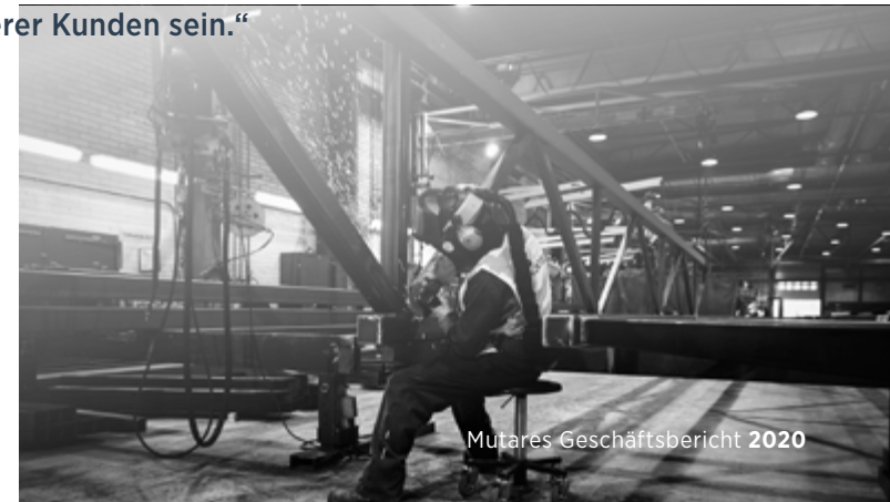
Fertigungsteile für eine Autobahnbrücke
